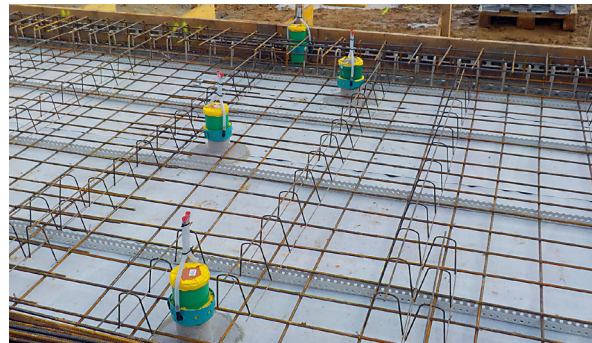
Drunterleiste Typ IV ist nicht zulässig
